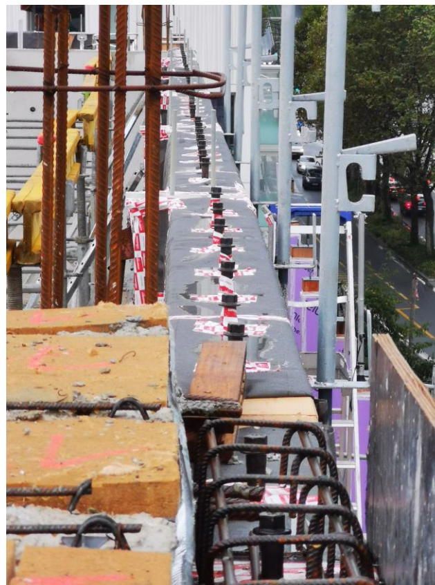
Assemblage poutres épicea-dalles BB (A2c préfa)
