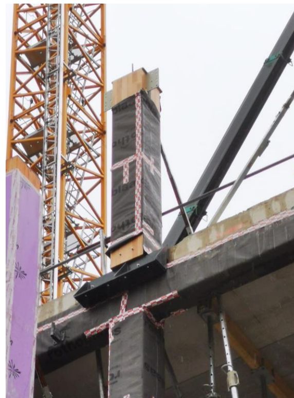
Poteaux hêtre mis en œuvre sur dalle BB (A2c Préfa) et en lien avec une poutre épicéa
