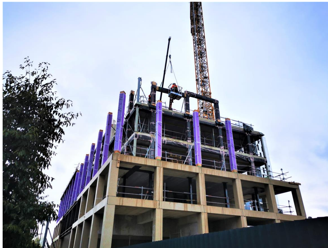
2 premiers niveaux béton / Poteaux doubles étages loggias en pin Douglas, poteaux intérieur hêtre, poutre épicéa, dalle bois béton
