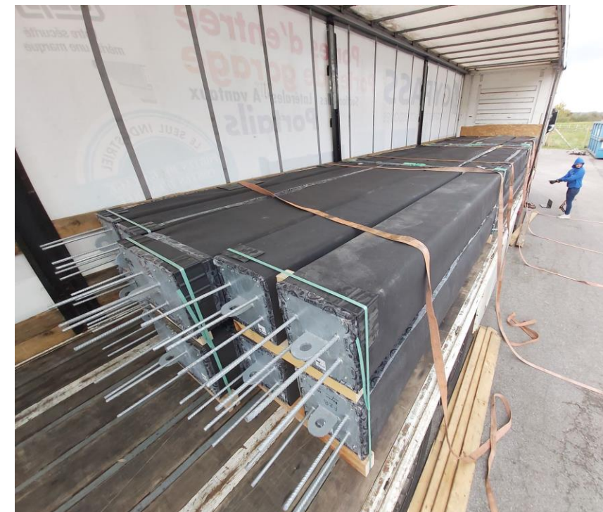
Chargement et livraison à l'avancement
