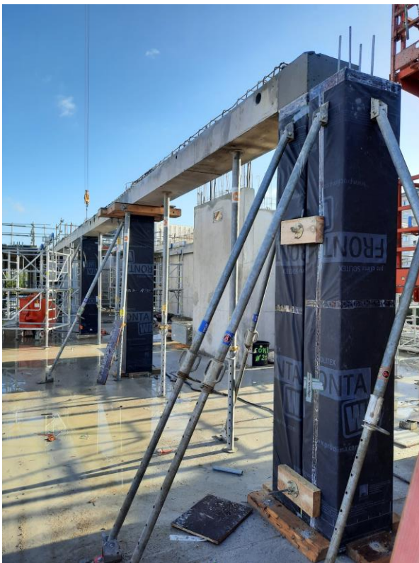
Poteaux étayés lors de la réalisation des clavetages
